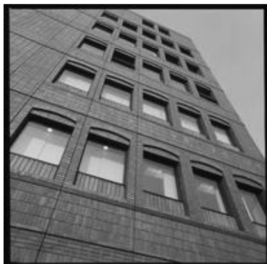
写真1 昔のちんや本社ビル
